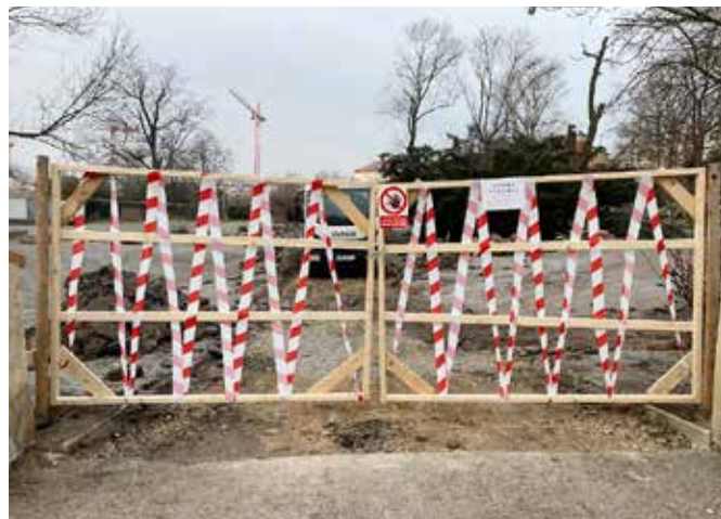
■ Během stavby je vstup do parku veřejnosti z důvodu bezpečnosti zakázán.
