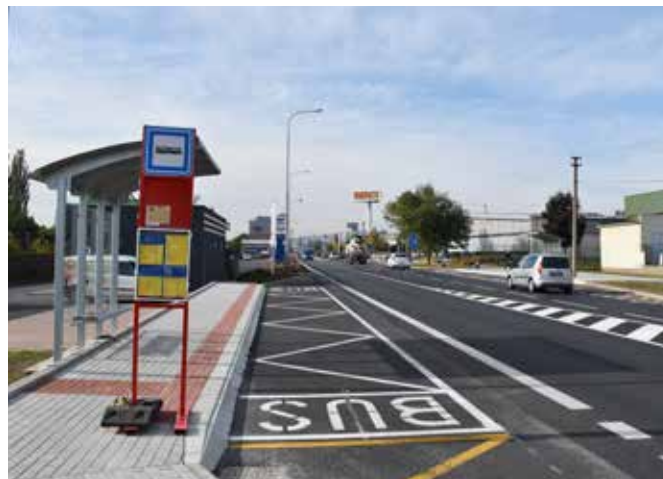
■ V rámci rekonstrukce Plzeňské ulice Beroun inicioval vznik nové zastávky proti Lidlu.
