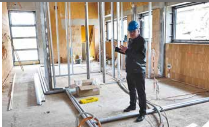
■ Součástí stavby jsou i kanceláře pro vedení školky.
