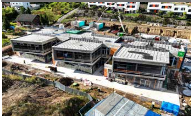
■ Pohled na stavbu Mateřské školy Máchovna.
