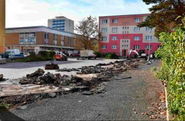
■ Oprava Švermovy ulice začala rekonstrukcí parkoviště u Hospodářského dvora.
