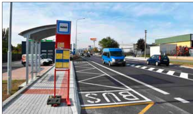
■ V rámci rekonstrukce Plzeňské ulice se městu Beroun podařilo vybudovat novou autobusovou zastávku proti Lidlu ve směru na Beroun.
