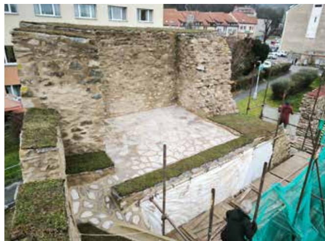
■ Rekonstrukce bašty míří do finále.
