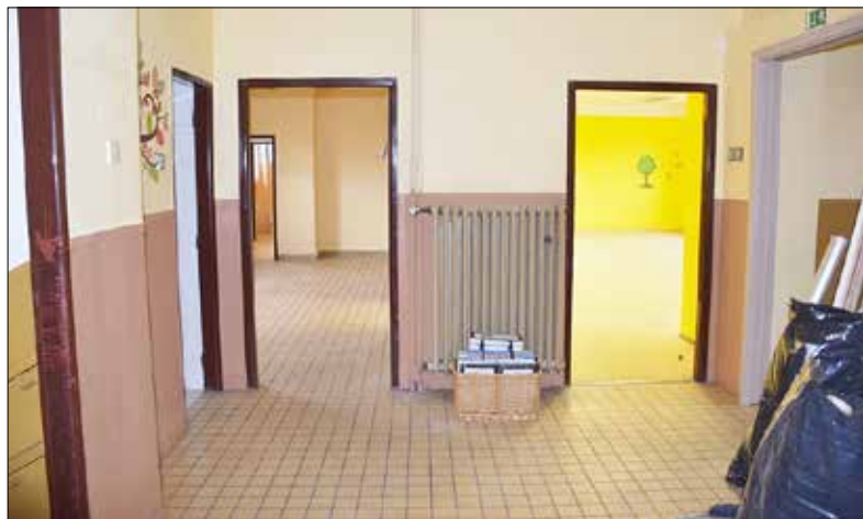
■ Poslední pohled na vyklížené prostory chodby, šatny a jedné ze tříd před tím, než přijdou dělníci.
