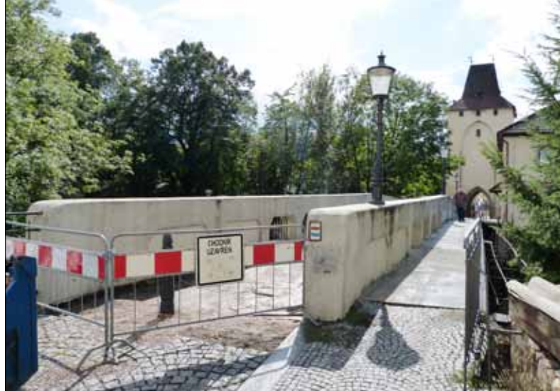
■ Oprava mostu u Venediku. ■
