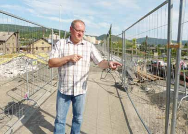
■ Místostarosta Michal Mišina kontroluje průběh oprav mostu na Zavadilkách.
