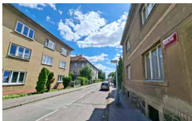
■ V ulici Vorlova a přilehlých komunikacích bude do listopadu probíhat oprava plynovodu.
