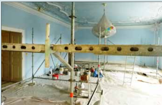
V obřadní síni berounské radnice je po dokončení klimatizace vše připraveno na malování. V první polovině prosince přijde na řadu pokládka koberec a věšení nových závěsů. Od ledna by pak měla tato reprezentativní místnost opět sloužit veřejnosti.
