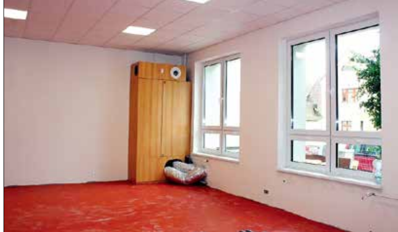
■ Z původní jídelny vzniknou nové učebny, ve kterých se právě dokončuje rekonstrukce.
