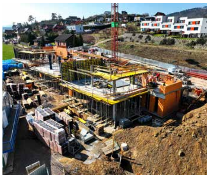
■ Stavba nové mateřinky Máchovna.
