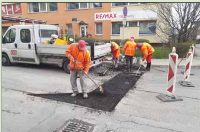
■ Zásah techniky se vyžádala i ulice Tyršova, kde bylo potřeba upravit porouch vozovky.
