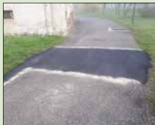
■ Před hřbitovem je opravený povrch cesty, který byl po zimě rozpraskaný a ztěžoval lidem chůzi.
