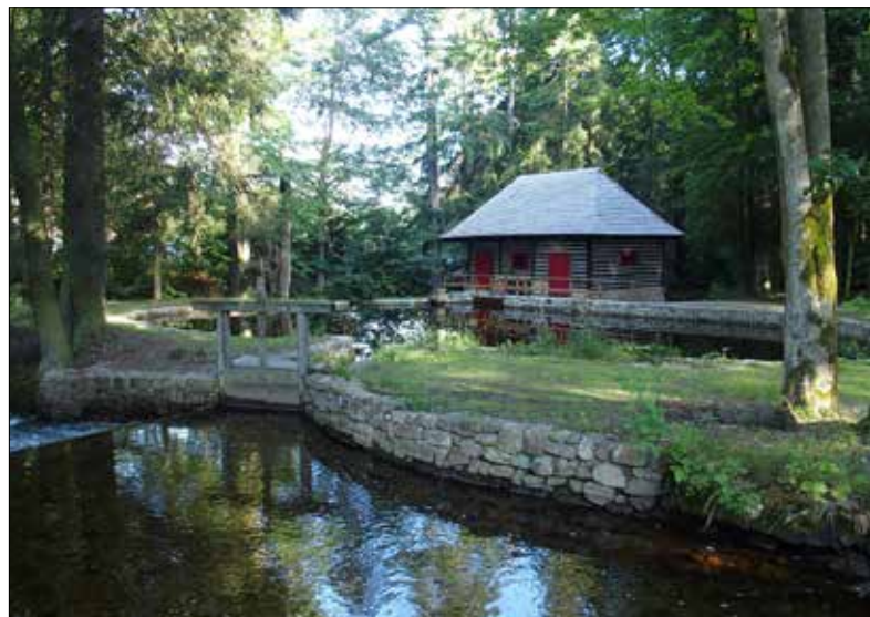
■ Malá vodní elektrárna
