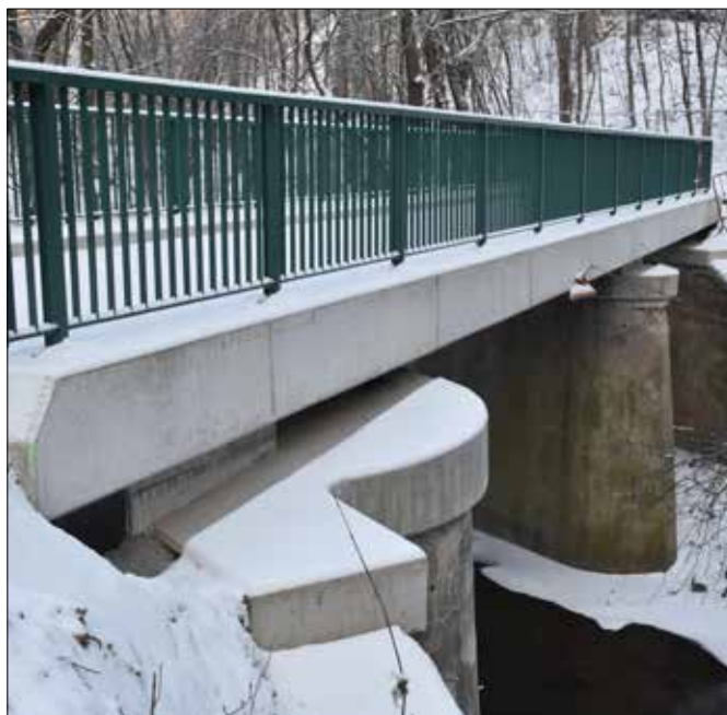
■ Nově opravený most přes Kačák.
