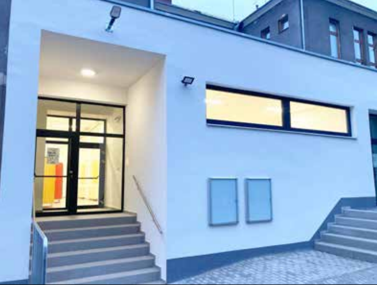
■ Nový vstup do šaten na Jungmannově základní škole.
