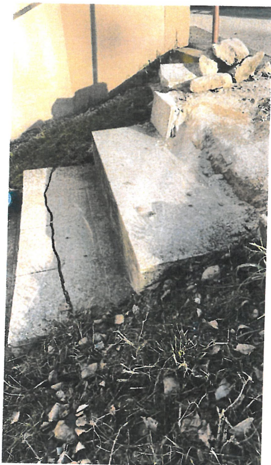
Foto 1. – Schodiště před Čs. armády čp.54 (bod 82.)
