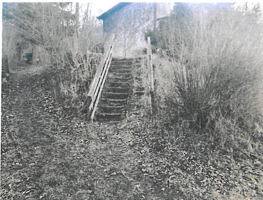
Foto 2. – Schodiště Strmá (bod 92.)
