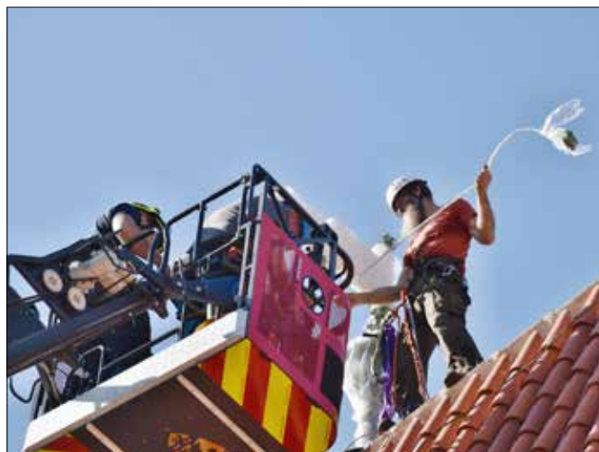
■ Lehkost, s jakou se pracovník firmy Lanostav při usazování bání a korouhvi pohyboval po střeše 30 metrů nad zemí, byla obdivuhodná.
