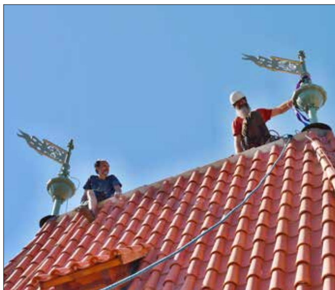
■ Instalace nového hromosvodu, to je úkol pro hromosvodáře, který vystoupal na střechu u brány hned, jak byly korouhve a makovice na svém místě.
