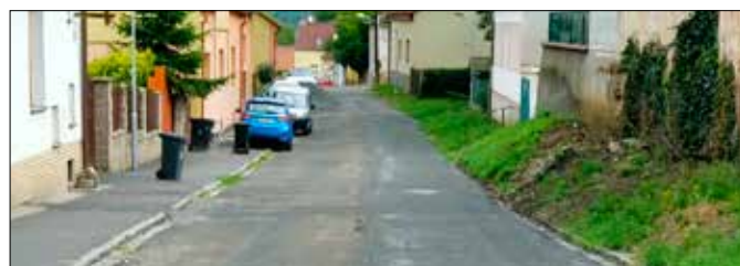
■ Komunikace na Zavadilce dotčené výstavbou kanalizace budou mít nové povrchy.
