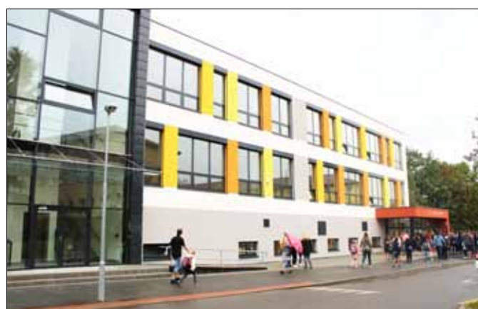
■ Nové třídy v mateřské škole Drašarova v Komunitním centru, pokračující rekonstrukce na závodské základní škole a především dokončená přístavba na základní škole v Preislerově ulici (na fotografii). To jsou stěžejní investiční akce v uplynulém roce v oblasti školství. Nutno ale podotknout, že rozhodně nebyly jediné. Na jednotlivých školách a mateřinkách se prováděla také řada úprav a oprav, jako je například výměna oken na ZŠ na Wagnerově náměstí nebo realizace environmentálních zahrad ve dvou berounských školkách.
