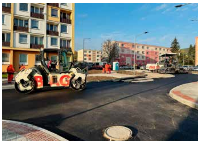
■ V říjnu začala pokládka asfaltového povrchu ve Švermově ulici.
