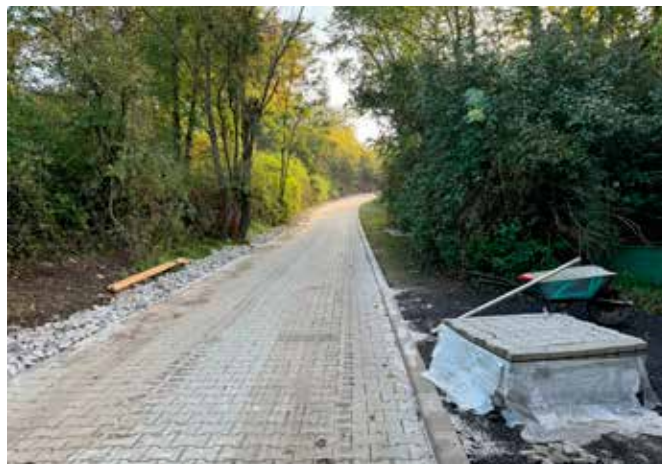
■ Při rekonstrukci ulice U Vápenice vedoucí ke kynologickému cvičišti byla zčásti použita zámková dlažba.
