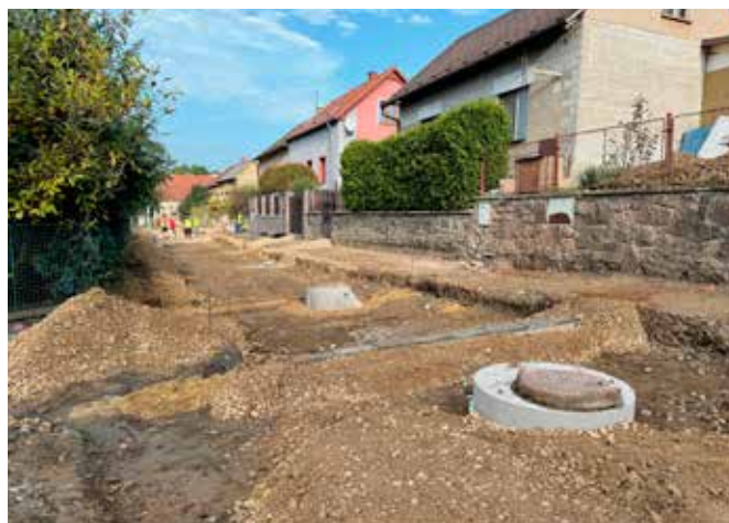
■ Na Závodí probíhá rekonstrukce ulice U Dobré vody.
