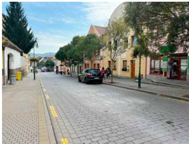
■ Pokud počasí dovolí, začne ještě letos předláždění druhé části Havlíčkovy ulice.
