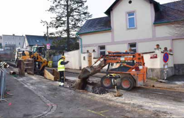
■ V lednu začala staoba kanalizace na Zavadihlce.
